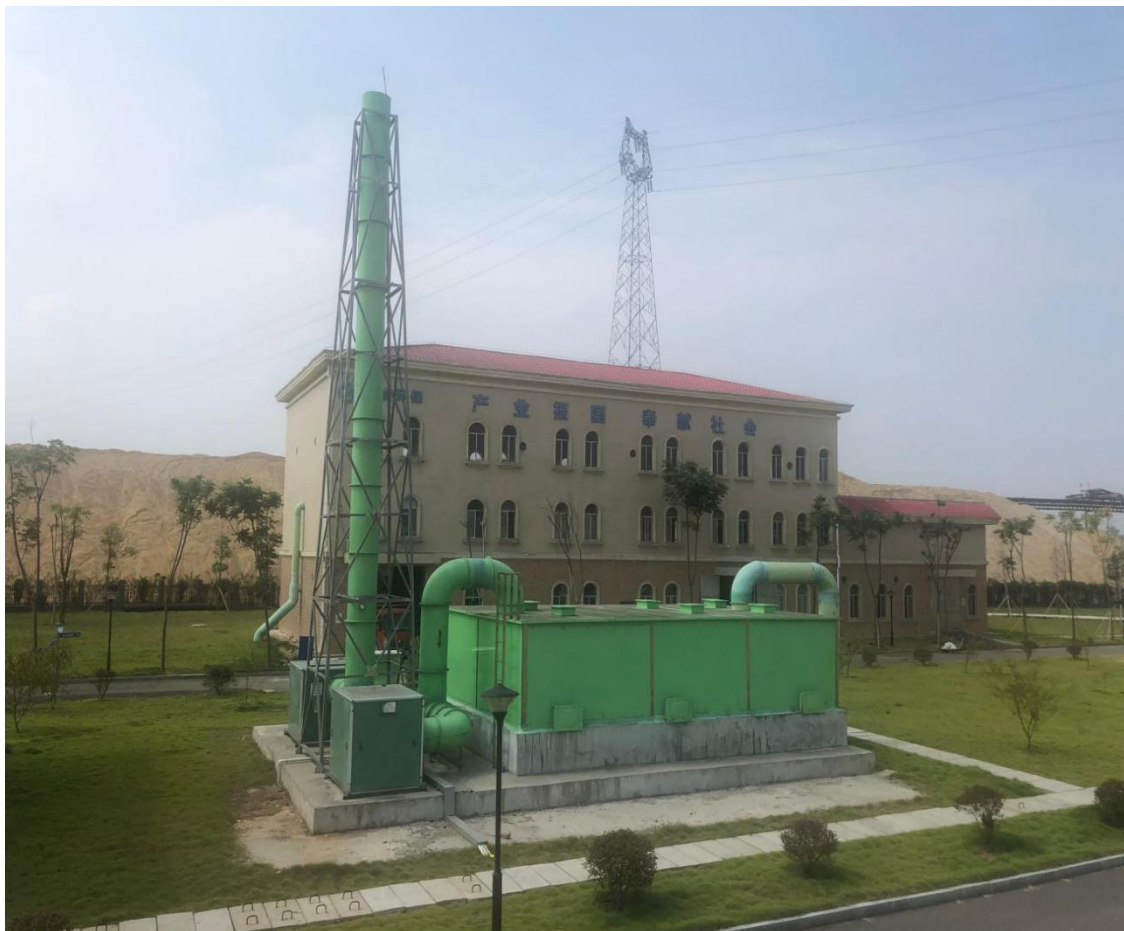
除臭装置+15 米排气筒
