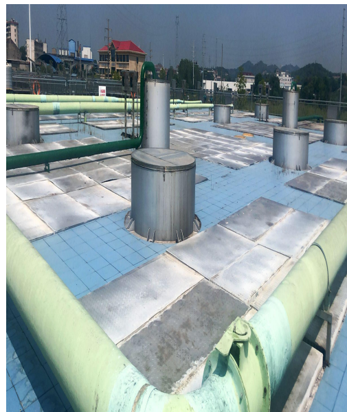
除臭装置+15 米排气筒
