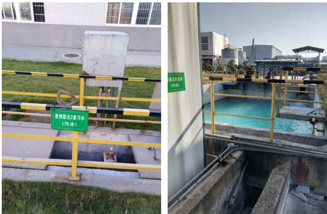
车间污水收集池
